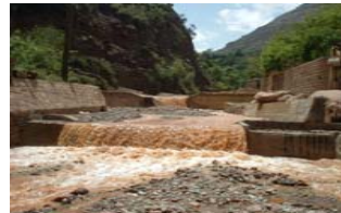
Petits seuils de stabilisation sur l'affluent Tighazrit (Ourika).
