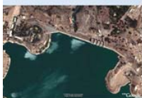
Barrage Lalla Takerkoust doté d'une centrale hydroélectrique
