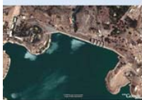
Barrage Lalla Takerkoust doté d'une centrale hydroélectrique
