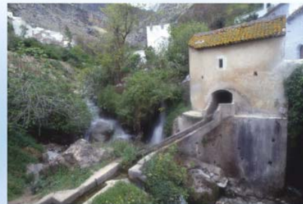
Moulin à eau dans la ville de Chefchaouen, il utilise directement la poussée de l'eau qui s'écoule pour faire tourner une roue.
